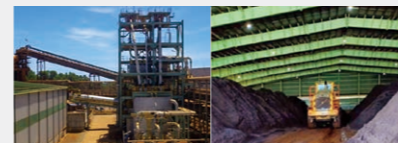
クロマイト製造設備と製品置場
