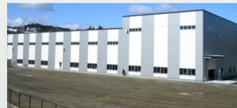
住鉱エナジーマテリアル（株） 楢葉工場（福島）
