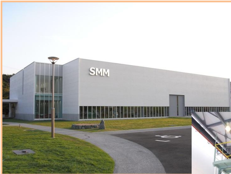
▼人材開発センター 王子館 危険体感・設備技術（09年10月竣工）
