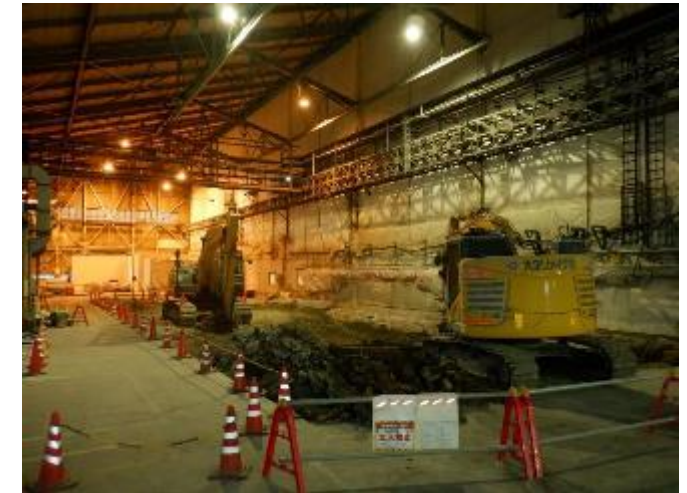
プラント建設状況
