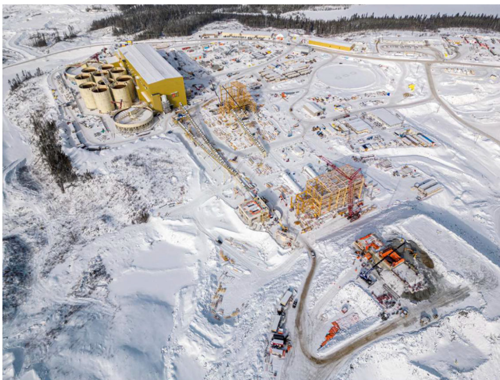
【コテ金開発プロジェクト(カナダ)建設風景（2023年1月撮影）】
