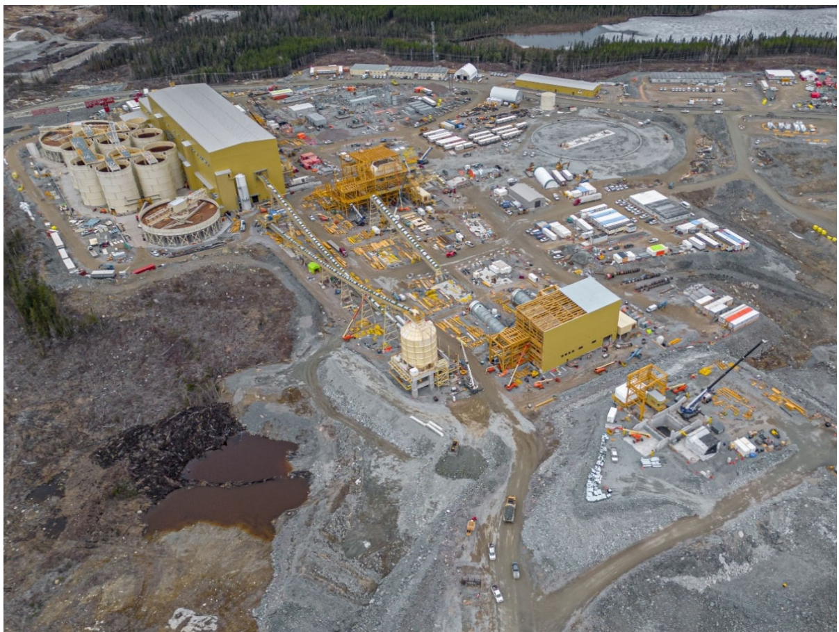
【コテ金開発プロジェクト(カナダ) 建設風景（2023年4月撮影）】
