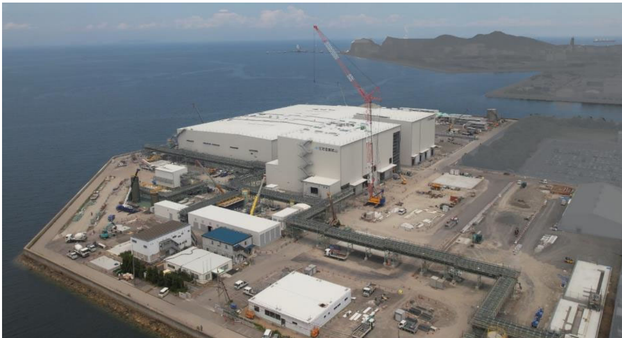
【車載用正極材増産に向けた新工場(愛媛県)建設風景 (2023年7月撮影)】
