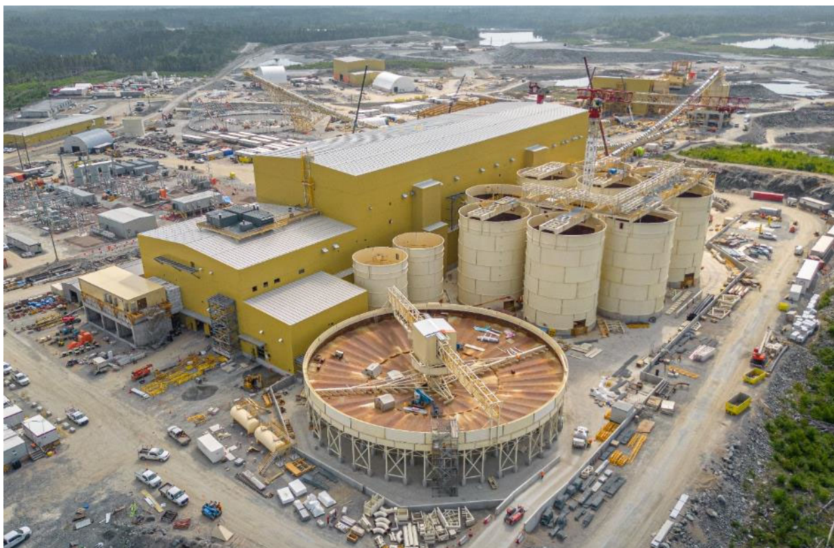
【コテ金開発プロジェクト(カナダ) 建設風景 (2023年6月撮影)】
