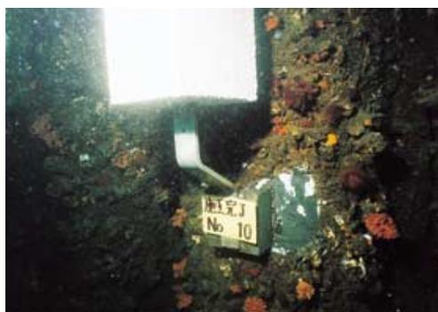
電気防食(アルミニウム合金陽極)装置の水中取付状況
