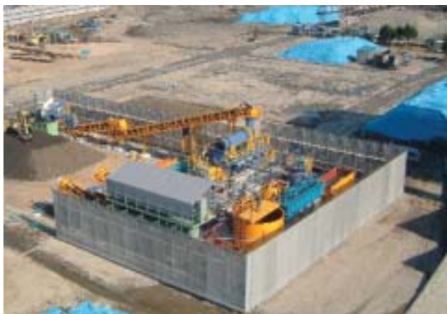
油脂汚染土壌洗浄装置
