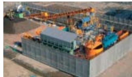
スミコンセルテック(株)土壌修復工事
