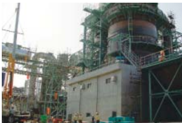
東予工場硫酸製造設備（亜硫酸ガスを回収）
