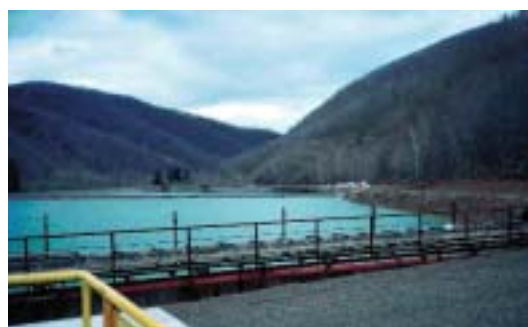
鴻之舞事務所 沈澱池
