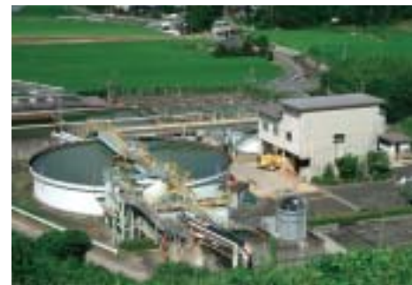
本山坑水処理施設
