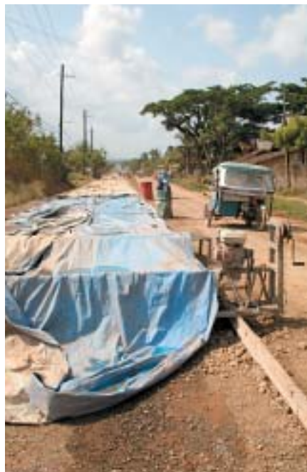
コーラルベイ ニッケル社の工場と港を結ぶ道路のコンクリート舗装工事
