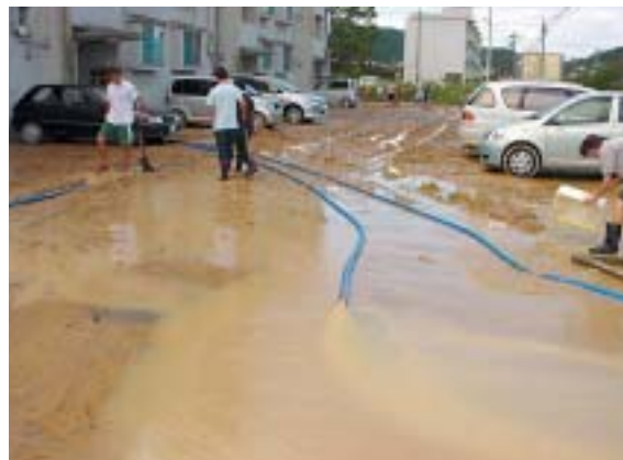
ボランティア活動(土砂除去作業)
