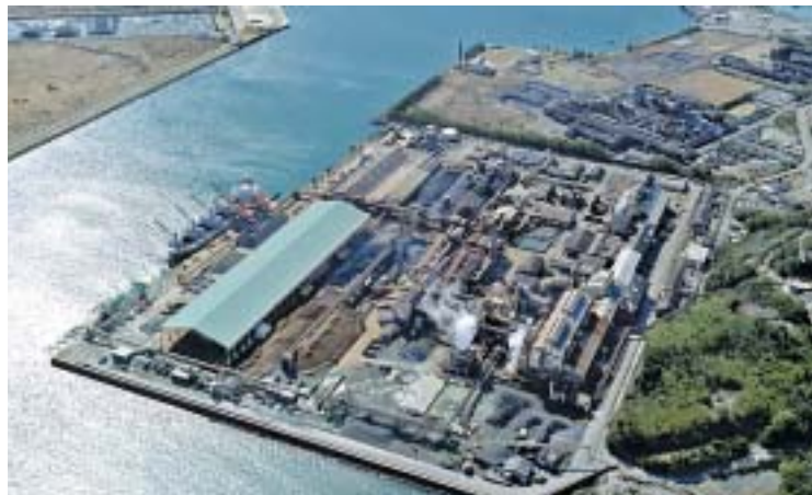
(株)日向製錬所全景(宮崎県)
