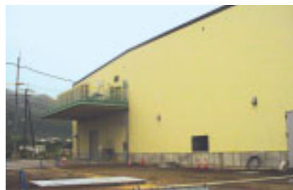
建設中の2層めっき基板工場(愛媛県)
