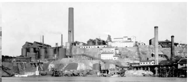
昭和14年(1939)アンモニアを使って亜硫酸ガスを中和する工場が竣工した
