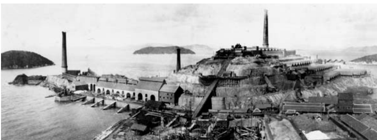
明治38年(1905)亜硫酸ガスによる煙害を根絶するために銅製錬所を瀬戸内海の無人島・四阪島に移転した
