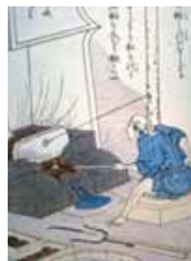
粗銅に含まれる銅と銀を採取する製錬法「南蛮吹き」
