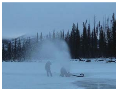
ウィンターロードの造成 気温が高く結氷が不十分だと、水をまいて氷を厚くしなければなりません
