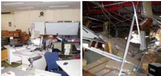
住鋳テック(株)仙台工場内設計室 地震直後の様子
