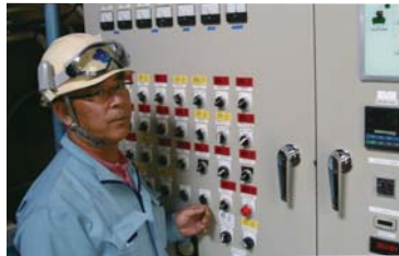
▲坑水を中和処理する工場での制御基盤の点検
