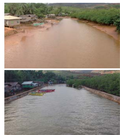
▲浚渫・護岸工事前(上) 浚渫・護岸工事後(下)
