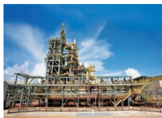
タガニートHPALプラント全景
