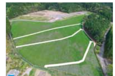
大口第1鉱さい堆積場の安定化工事(左)と工事後の緑化状況(上)
