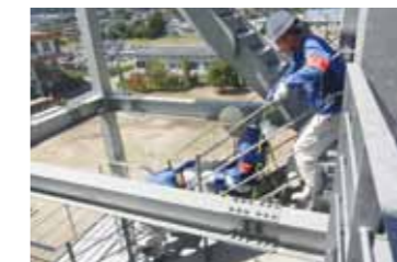
負傷者の階段避難訓練 (株伸光製作所)
