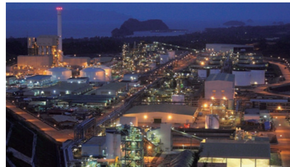
タグニートHPALプラント
