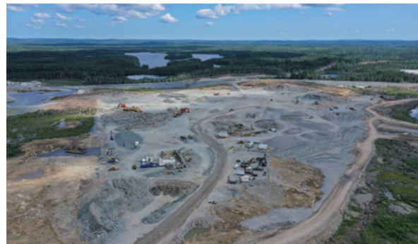
コテ金開発プロジェクト建設現場
