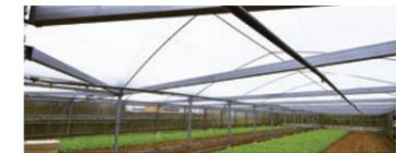
近赤外線吸収材料セシウムドープ酸化タングステン(CWO®)を練り込んだ天幕による農業用ビニールハウス
