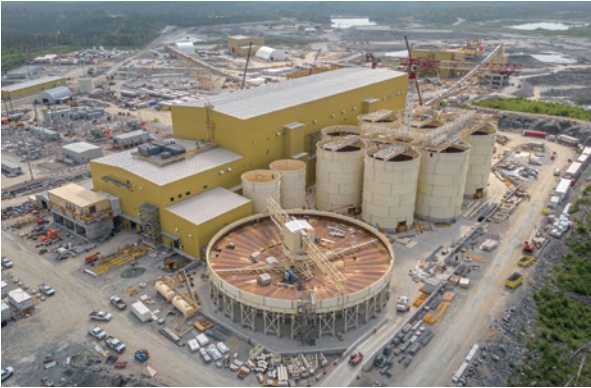
コテ金開発プロジェクト選鉱場エリアの建設状況（2023年4月現在）
