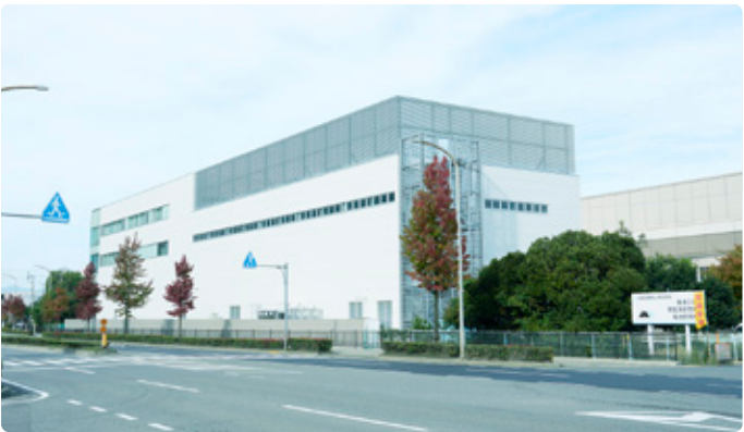
電池研究所 第2開発棟
