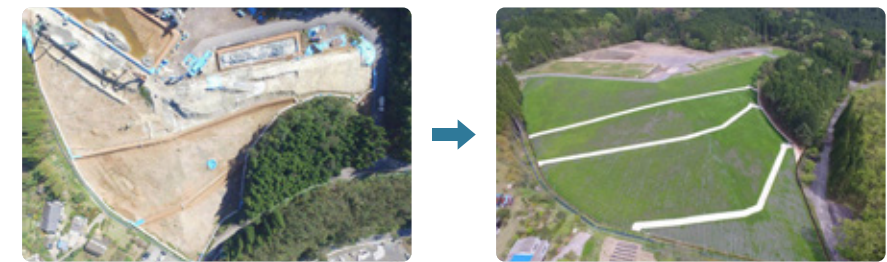
大口第1鉱さい堆積場の安定工事
