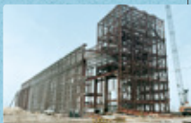
建設中の東予製錬所
