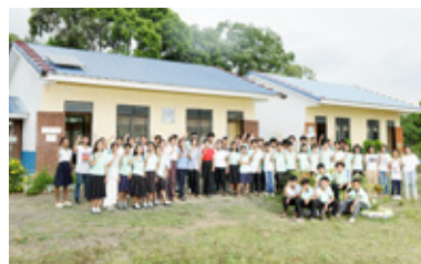
フィリピンの拠点近隣の町に建設した教室
