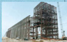
建設中の東予製錬所
