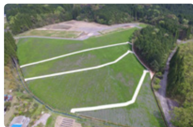
工事後の緑化状況
