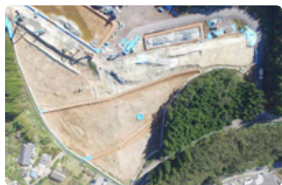
大口第1鉱さい堆積場の安定工事
