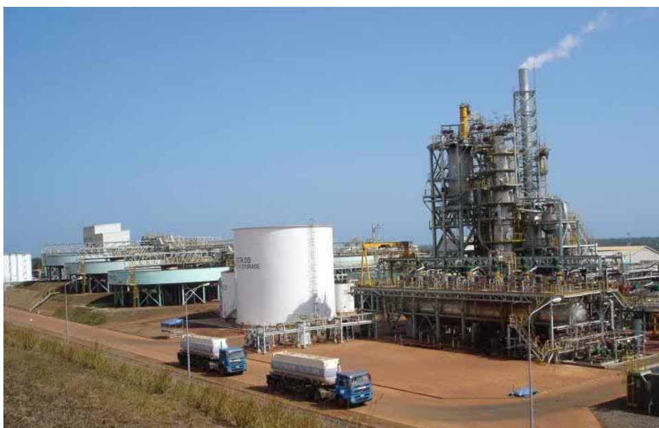
(コーラル ベイ ニッケル で稼動する HPAL 施設)
