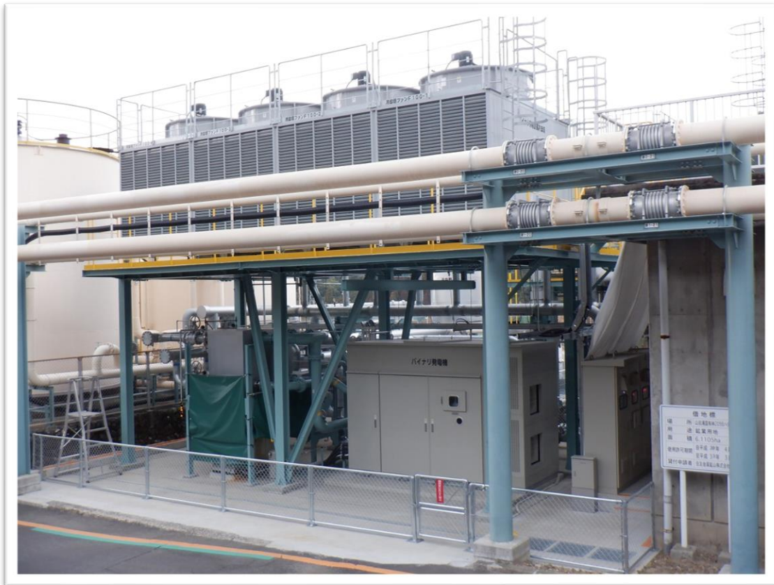
※バイナリー発電設備の外観
