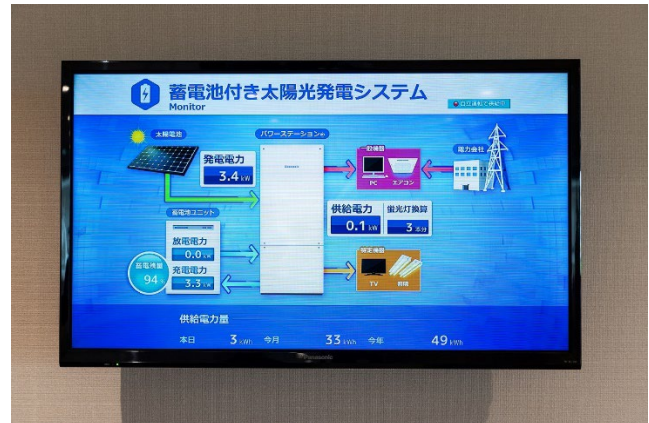
【太陽光発電システム】
