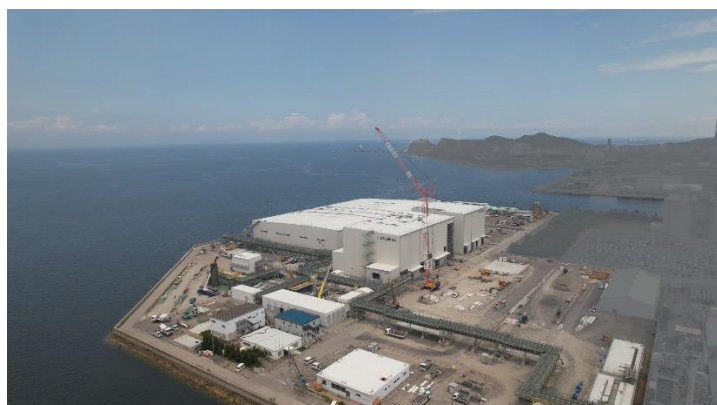
（左）愛媛県新居浜市で建設中の工場
