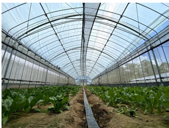
SOLAMENT を利用したビニールハウス
